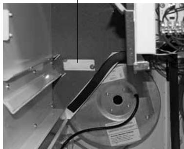
**OBS: Kontrollera att tilluftsfläktens kabel inte kommer för nära den elektriska luftvärmaren.**
