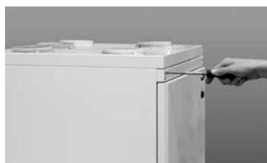
Lås ILTO W80 på plats genom att dra åt skruvarna fram till.
